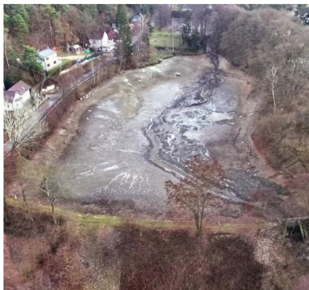
Celkový pohled na rybník (vpravo na fotce viditelný přeliv, vlevo napojení hráze na komunikaci)
