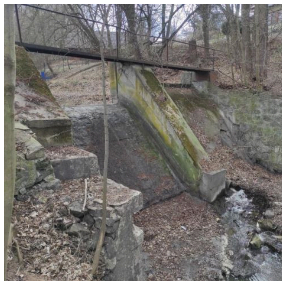
Pohled na současný bezpečnostní přeliv
